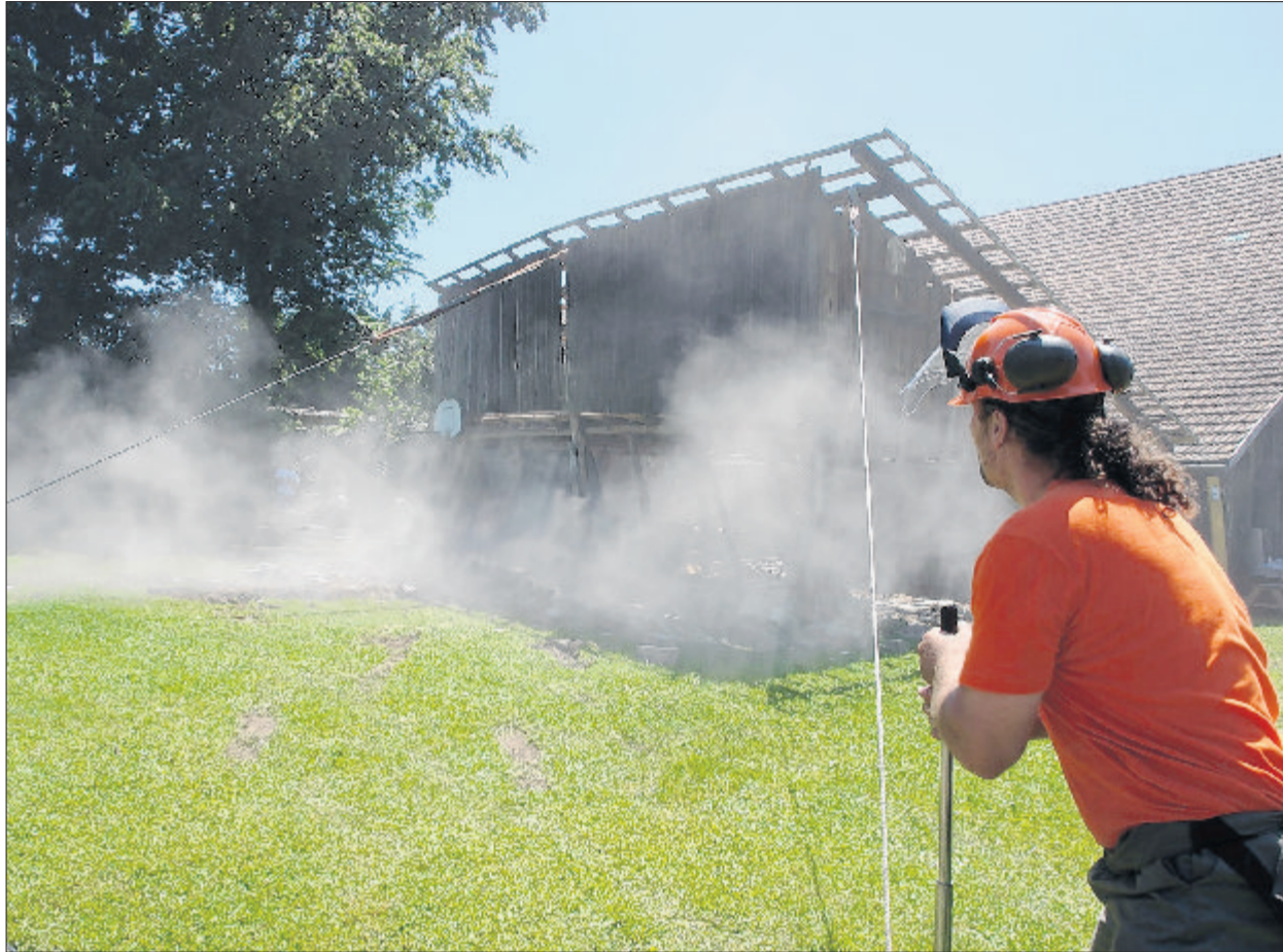
Mit Stahlseilen und Habeggern bringen die Zivilschützer den alten Lagerschuppen in Schwerzenbach zu Fall. (snk)
